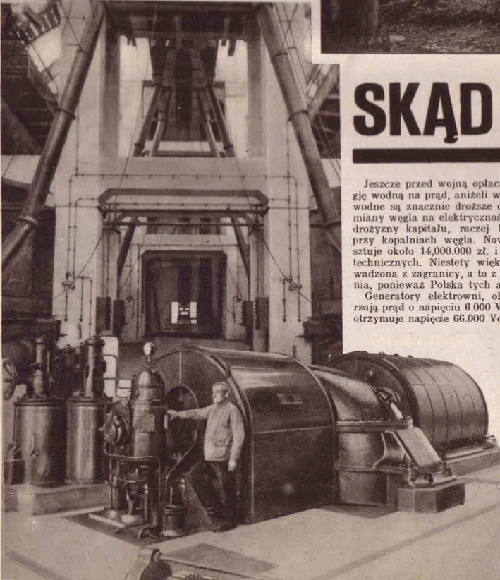
Hala maszyn i kotłownia. U dołu turbina parowa o sile 11.500 kw (stoi przy niej maszynista) obok generator, w górze kotłownia. Rurami, które widzimy, jest węgiel doprowadzany automatycznie do palenisk wprost ze zwołów w kopalni.
